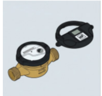
Uklanjanje radio adaptera s bežičnog stambenog vodomjera REDAC tipa MT-SMARTMESS-JS-REDAC-RADIO-WW
